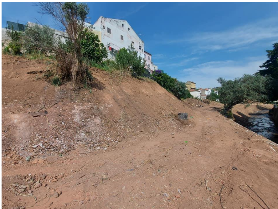
Figura 1 - Limpeza de Ribeiro em Odivelas pela empresa Rota Certa Ltd, contratada pela CMO: https://www.facebook.com/rotacerta.lda/posts/1472111636458098
